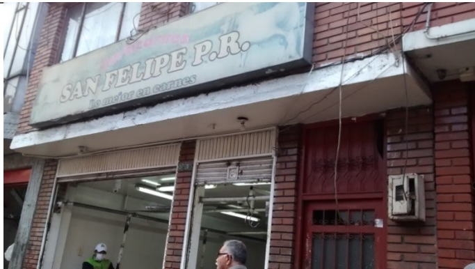
Fotografía No. 2: Visita de seguimiento al requerimiento al establecimiento COMERCIALIZADORA DE CARNES SAN FELIPE P R S A S, efectuada el día 21/07/2015
